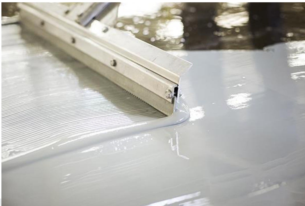
Foto: Aanbrengen vloeistofdichte beschermlaag.
