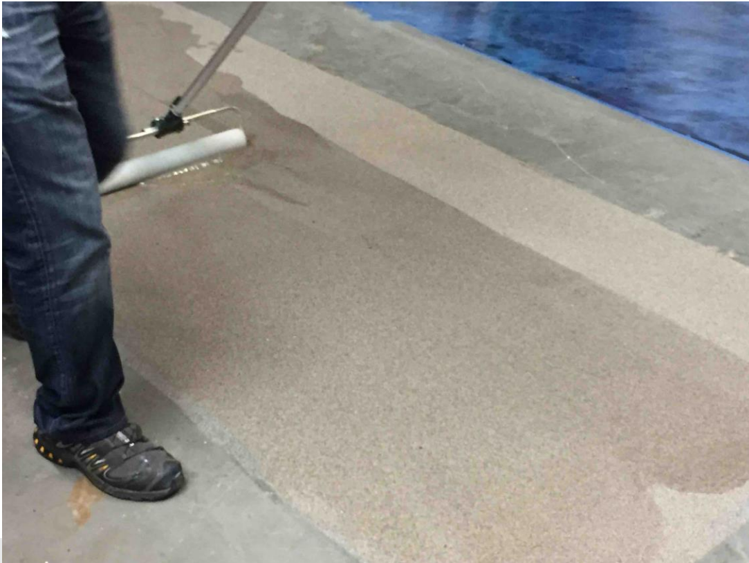
Foto: Aanbrengen primer.
